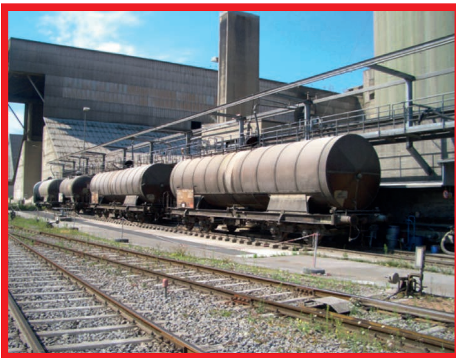
Nehoda v roku 2011: Špecializovaný dodávateľ bol privolaný vykonať všeobecnú kontrolu vagóna, ktorý sa používa na skladovanie odpadových rozpúšťadiel. Počas týchto prác sa u pracovníka prejavili známky dusenia sa spôsobeného výparmi – osoba, ktorá sledovala jeho činnosť zvonka, vnikla do nádrže, aby mu pomohla, pričom sa z dôvodu výparov začala tiež dusiť – ďalšia osoba, ktorá to videla, zrealizovala záchranný plán a obaja muži boli bezpečne vytiahnutí a ošetrení.
