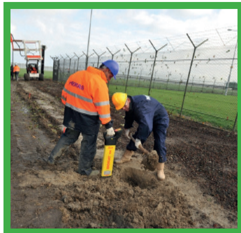
Kontrola prítomnosti podzemných inžinierskych sietí pred výstavbou oplotenia.
