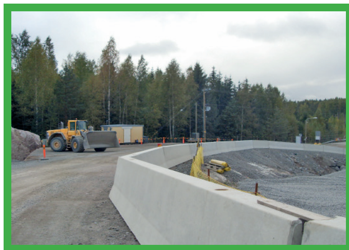
Ochranné bariéry z prefabrikovaných konštrukcií.
