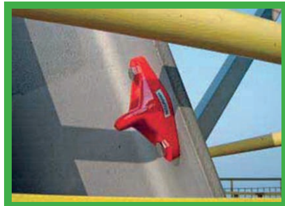
Kotviace body – inštalované v prípade potreby.
