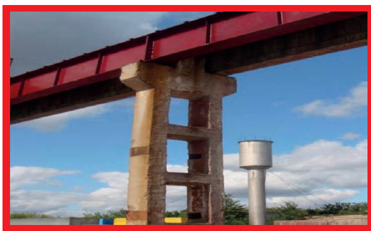
Smrteľné úrazy v rámci Skupiny – prípadová štúdia 2008: Dodávateľ počas zostupovania spadol z vyššieho poschodia. Pri určení rizík sa zistila potreba použitia systému MEWP (pojzdnej vysokozdvížnej pracovnej plošiny), ale žiadna sa nepoužila.
