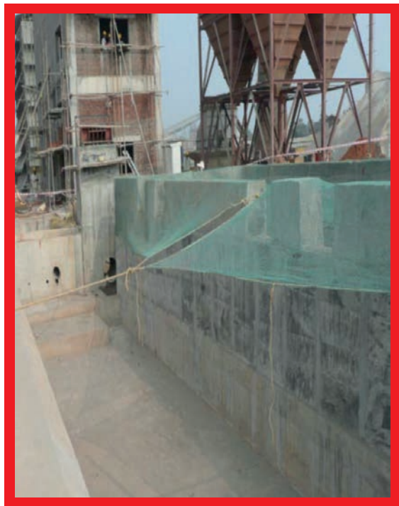
Smrteľná nehoda v roku 2011: Dodávateľ spadol pri prekračovaní múru počas budovania nadstavby.
