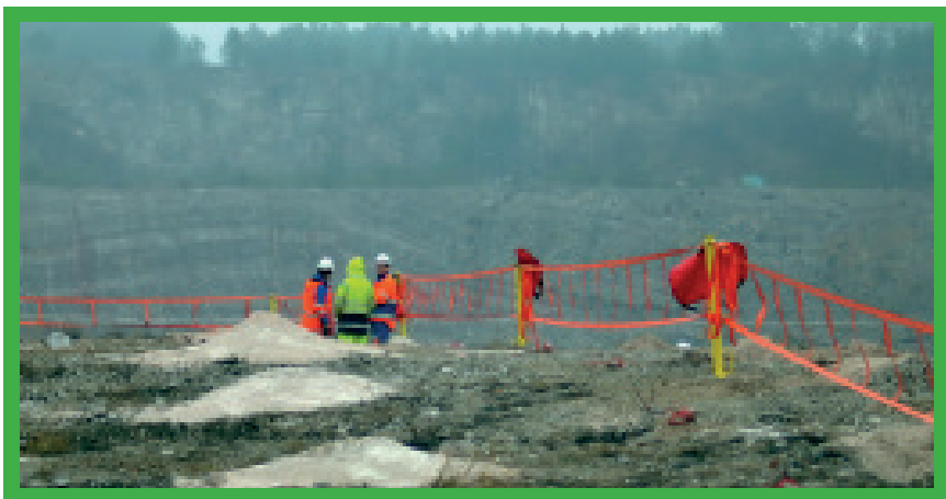
Systém bariér na lomovej stene.
