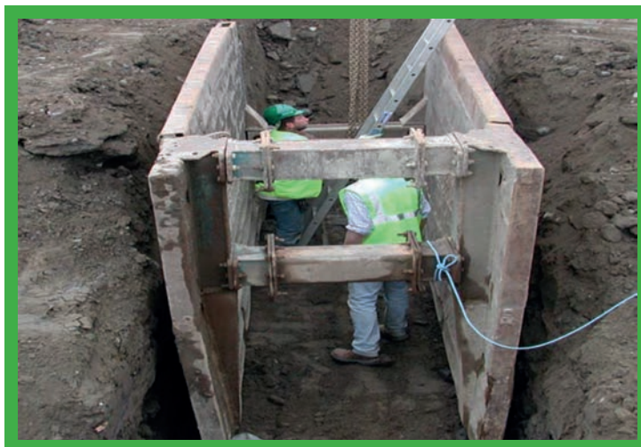
Paženie výkopu v praxi
