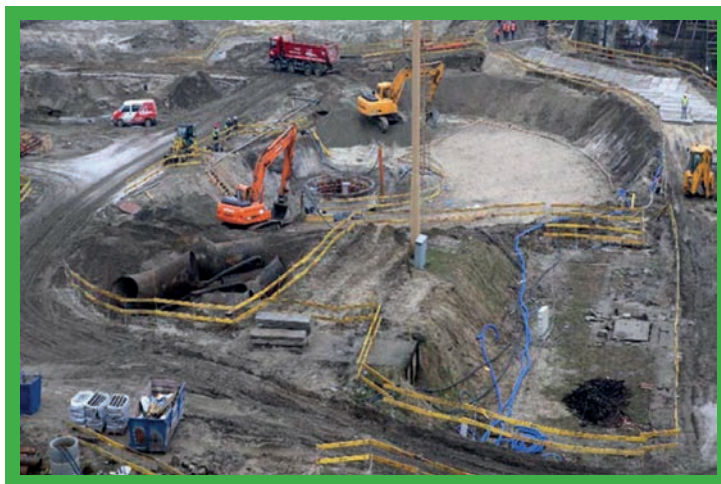
Riadenie dopravy na stavenisku.
