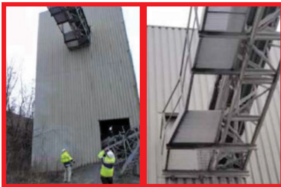
Smrteľná nehoda (nie na pracovisku CRH): Pracovník padol z výšky 14 metrov keď sa pod ním prepadla časť roštu podlahy. Upevňovacie skrutky roštu sa postupom času kvôli blízkemu vibračnému triediču uvolnili.
