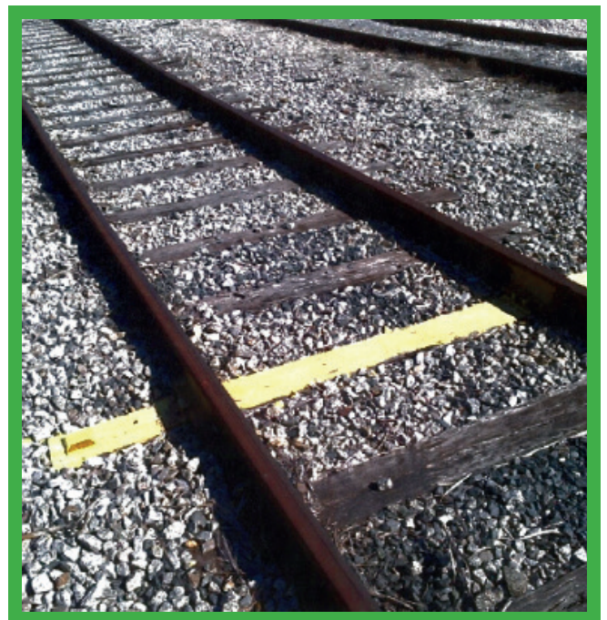
Markierungen zur eindeutigen Kennzeichnung der erforderlichen Halteposition für abgestellte Bahnwagen.
