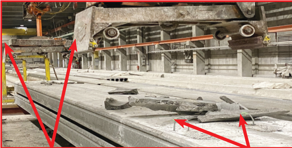
Die Hohlkörperplatte wird mit den Klemmen/Greifern eines Brückenkrans in Position gebracht.
