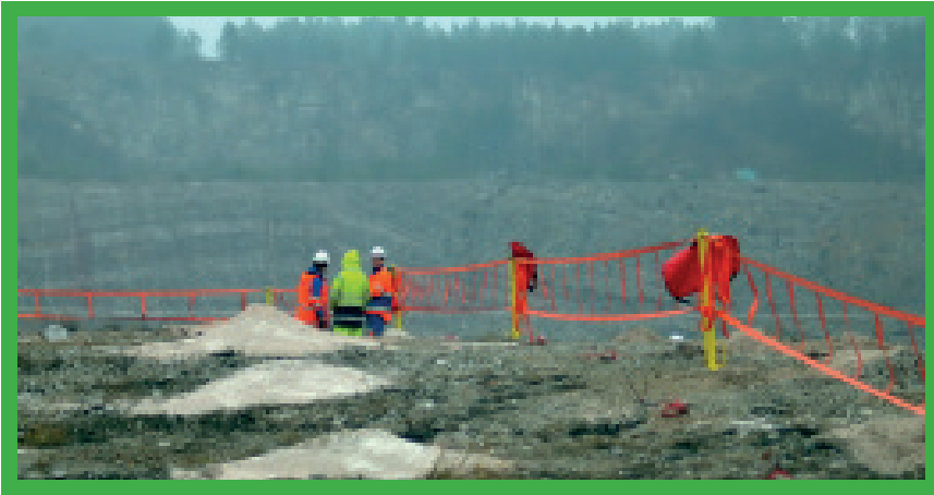
Absperrsystem an der Steinbruchwand.
