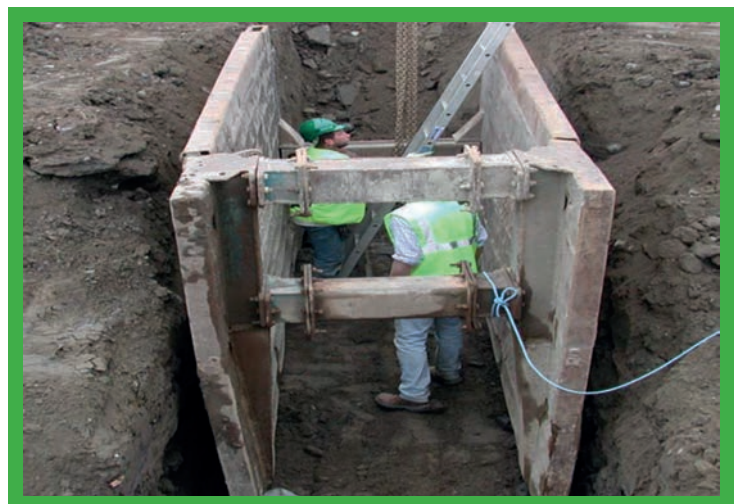
Verbauboxen im Einsatz.
