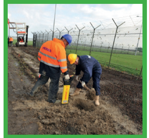
Überprüfung des Vorhandenseins unterirdischer Leitungen vor Errichtung eines Zauns.
