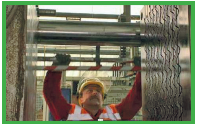
Mechanische Isolierung: Schutz einer Schiebetür (mechanisch + Vorhängeschloss).
