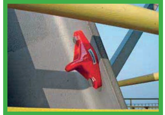
Zusätzliche Befestigungshaken zur Verwendung von Geschirren - Montage nach Bedarf.
