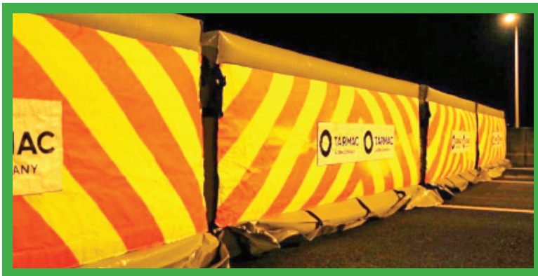
Aufblasbare Sicherheitsbarrieren: Im Design ähnlich wie Betonbarrieren, um Arbeiter, die am Straßenbau / an der Reparatur beteiligt sind, zu schützen.
