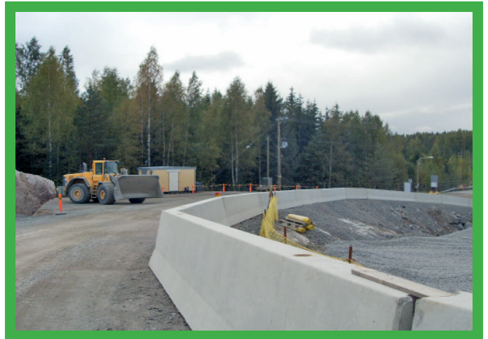
Kantenschutz mit Fertigbauteilen.
